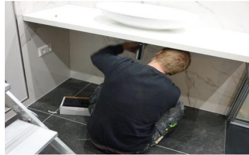
Weiter geht es mit dem anbringen des Design Syphon
